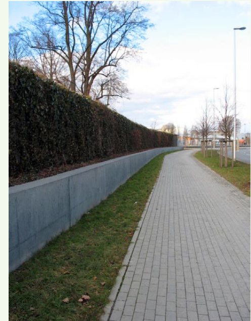
Hochwasserschutz für die Weiße Elster in der Stadt Gera
