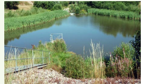
Naturnahes Regenrückhaltebecken Suhl-Struth mit Sand- und Geröllfang sowie Tauchwand
