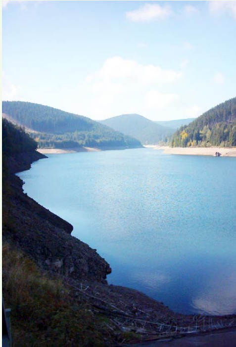
Trinkwassertalsperre Ohra im Thüringer Wald
